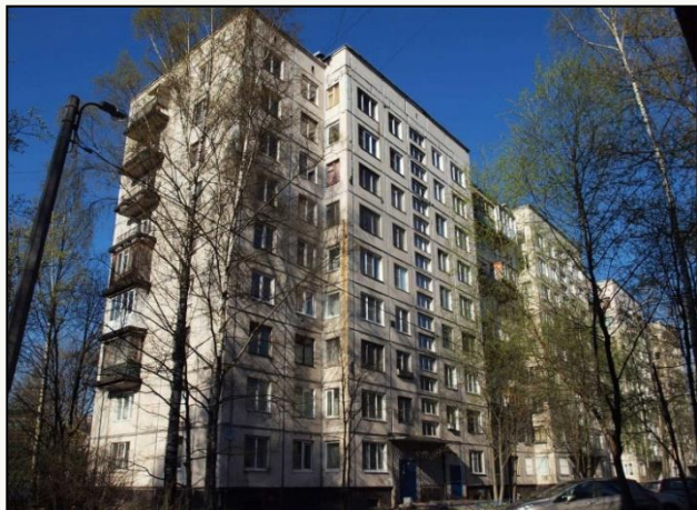
ТСЖ «Ручьевское» СПб, ул. Науки 28 к 3 Включили ремонт фасада на 2021-2023г.
