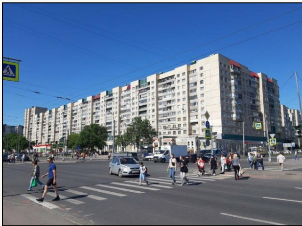
ТСЖ «Индом» СПб, Индустриальный пр., д.27 Приблизили срок ремонт ЦО с 2036-38г на 2021-2023г.
