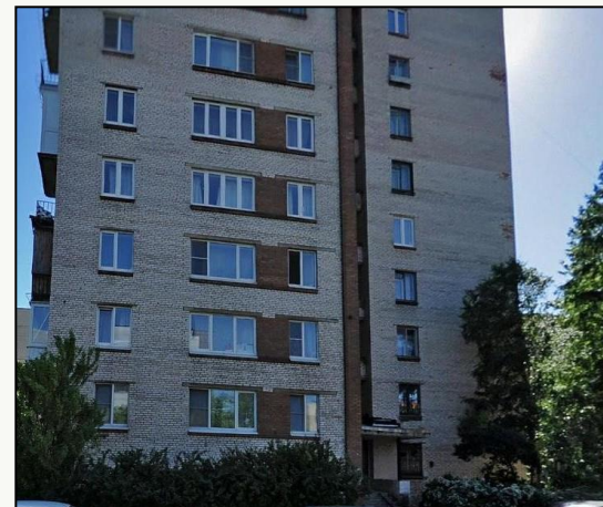
ЖСК №168 СПб, ул. Ключевая д.21, лит.А Приблизили срок ремонта ЭС с 2036-2038 На 2021-2023
